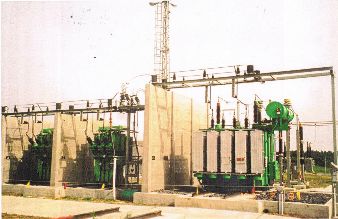
2 db. 4 kVA-es iker autó-transzformátor
