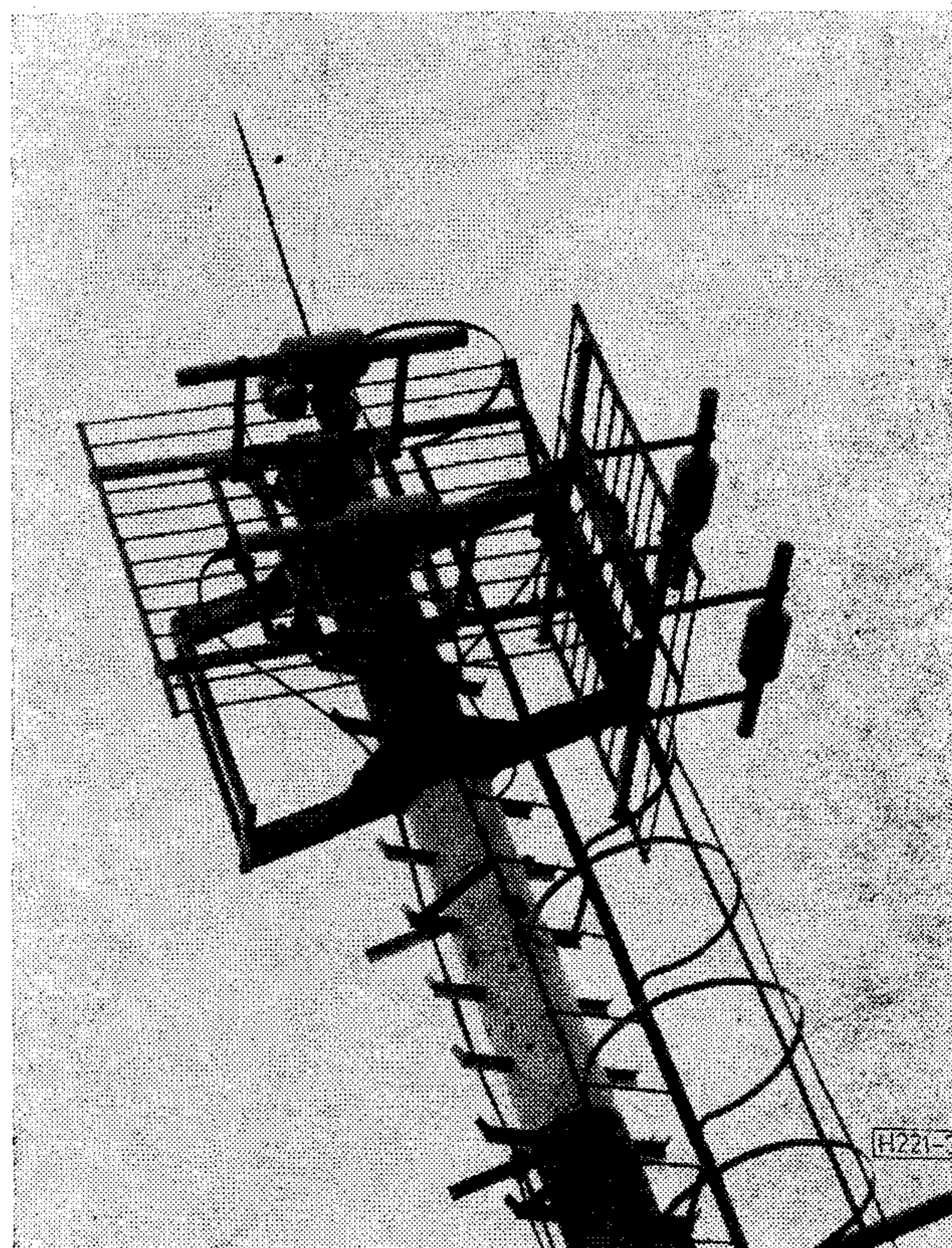
3. ábra. TV átjátszóállomás antennarendszere
